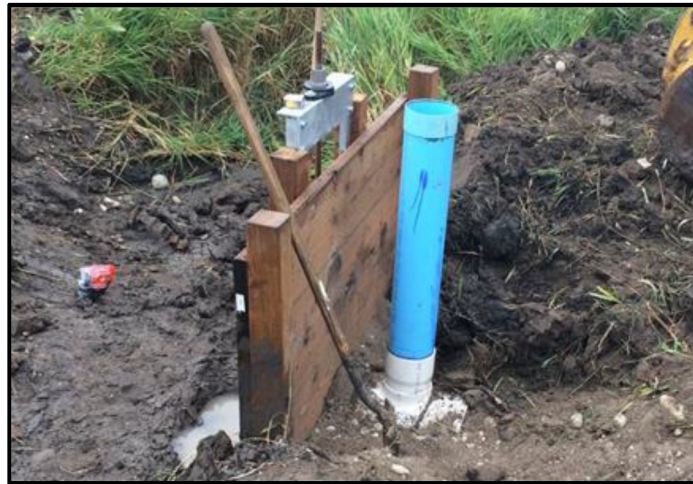
شکل ۴-۲۵- چاهک اندازه‌گیری با قطر، موقعیت و ارتفاع مناسب، نصب‌شده در دریچه اندازه‌گیری
