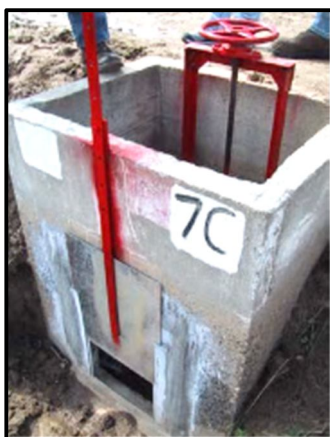
شکل ۴-۲۸- یک دریچه روزنه‌ای مستطیلی (دریچه جلویی) که اندازه‌گیری جریان را ممکن می‌سازد، هم‌زمان دریچه کشویی (دریچه پشتی) کنترل جریان را فراهم می‌کند
